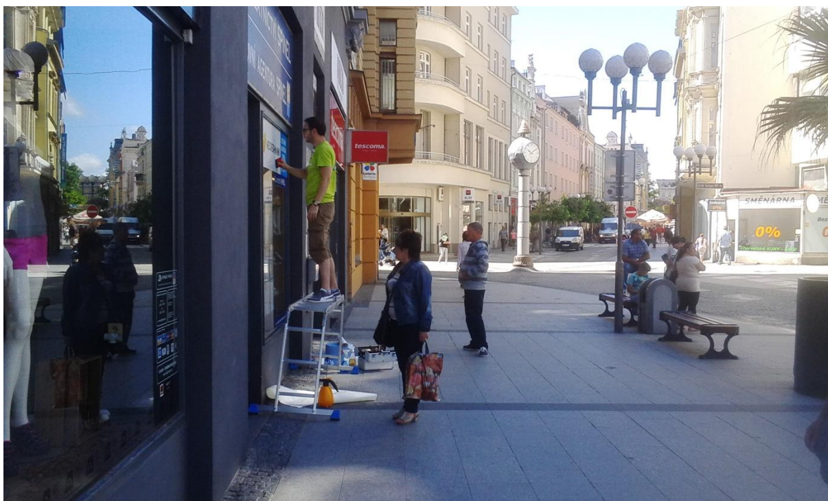
Obr. 4 Údržba - hrozící nebezpečí pro pracovníka i osoby s omezenou schopností orientace (ul. Ostrožná, Opava)
