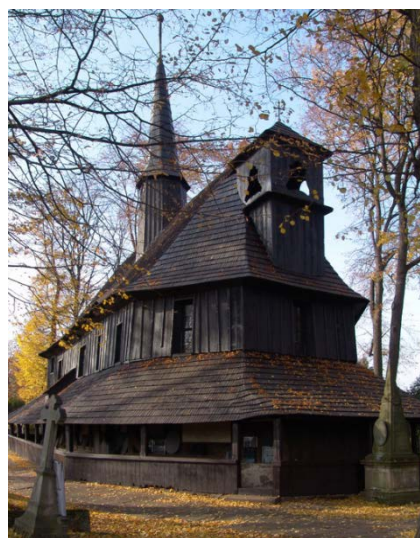
Obr. 1: Dřevěný kostel Broumov
