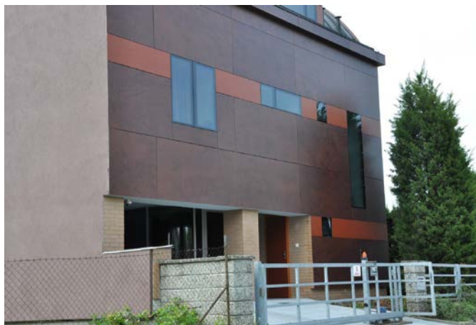
Obr. 1 Pohled na provětrávanou lepenou fasádu objektu [4]
