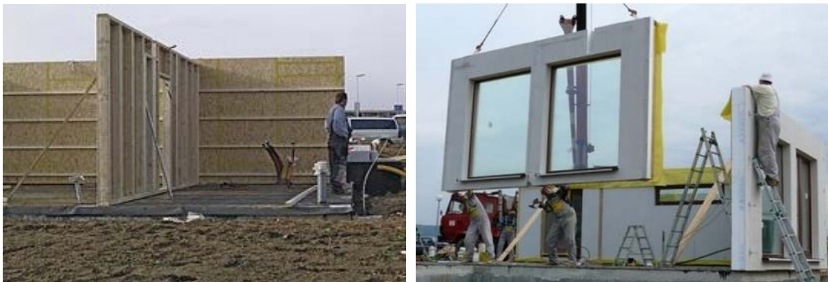
Obr. 6: Prefabrikovaný rám s opláštěním
