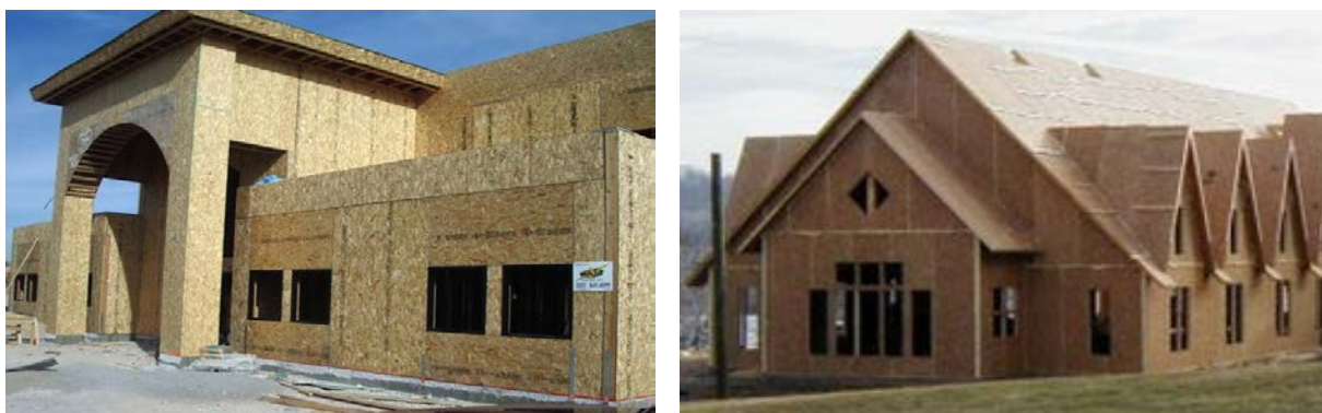
Obr. 7: Typické provedení stavby technologií SIPs
