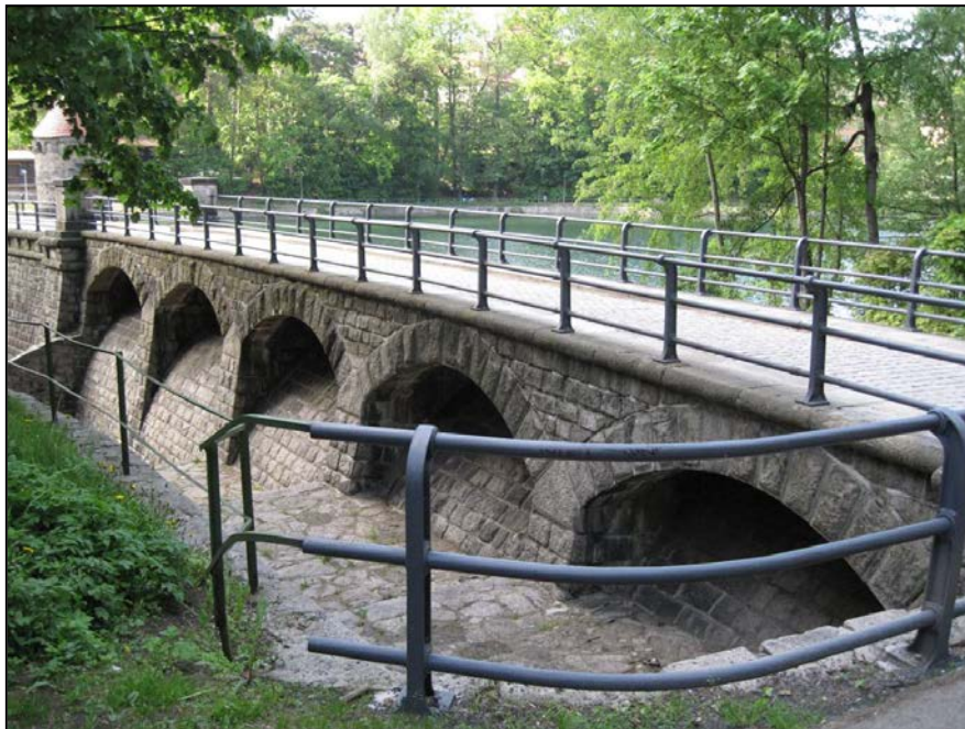
Obr. 2: Foto bezpečnostního přelivu a skluzu
