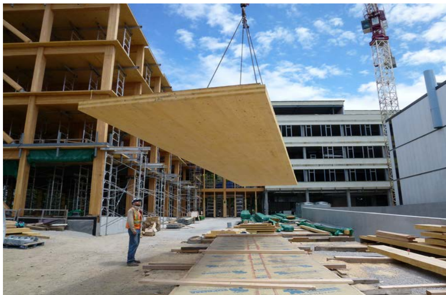
Obr. 4: Provádění stavby z masivních deskových panelů
