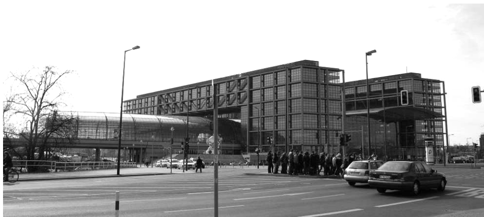
Rys. 10. Dworzec Berlin Hauptbahnhof (fot.: autor)
