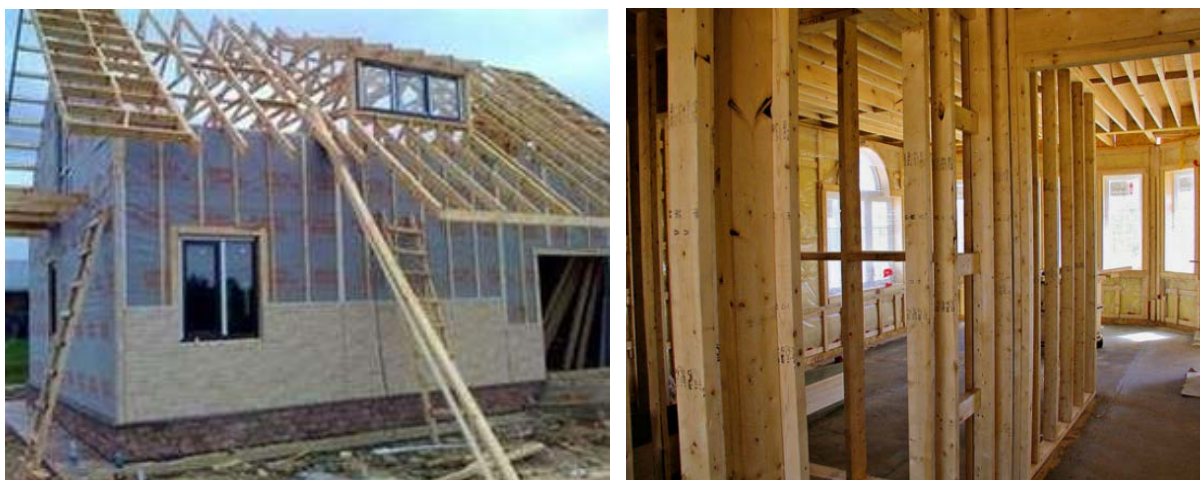
Obr. 4: Odhalená sloupková (rámová) konstrukce stavby
